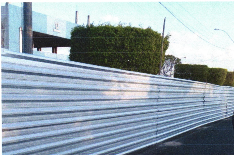
Foto 02 – TAPUME COM TELHA METÁLICA. AF_05/2018
