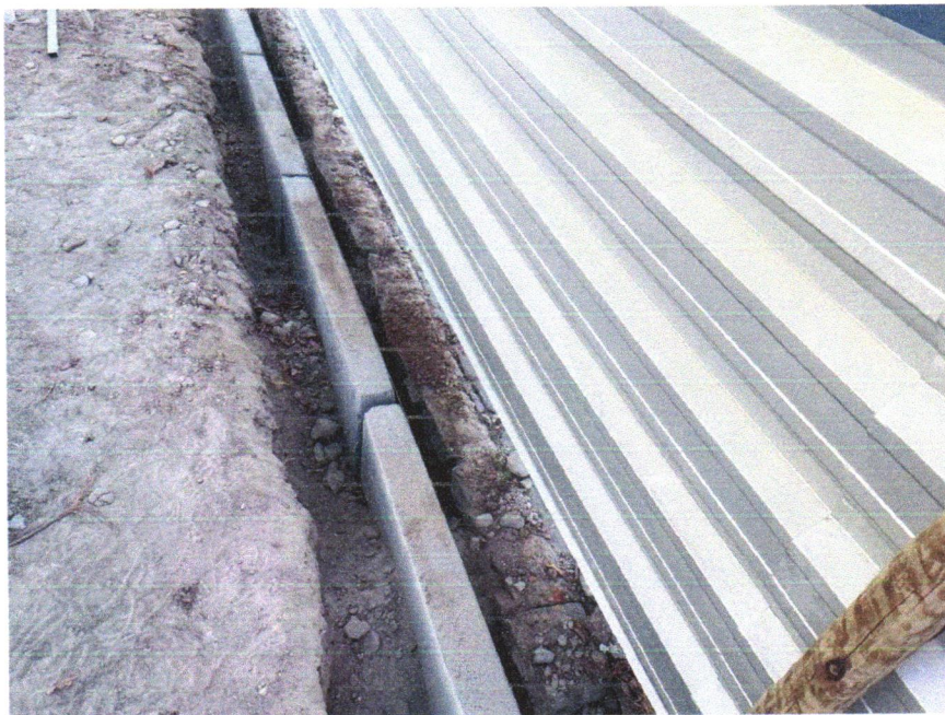
Foto 10 - ASSENTAMENTO DE GUIA (MEIO-FIO) EM TRECHO RETO, CONFECCIONADA EM CONCRETO PRÉ-FABRICADO, DIMENSÕES 100X15X13X20 CM (COMPRIMENTO X BASE INFERIOR X BASE SUPERIOR X ALTURA), PARA URBANIZAÇÃO INTERNA DE EMPREENHIMENTOS. AF_06/2016_P
