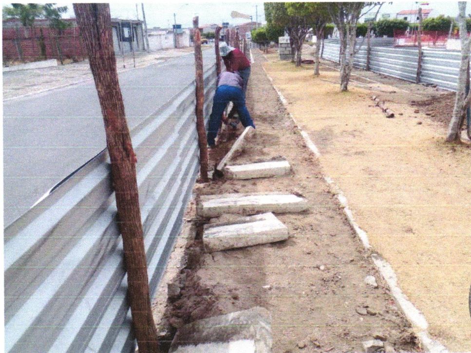
Foto 04 - RETIRADA DE MEIO-FIO DNER / ECONOMICO COM EMPILHAMENTO E SEM BOTA FORA
