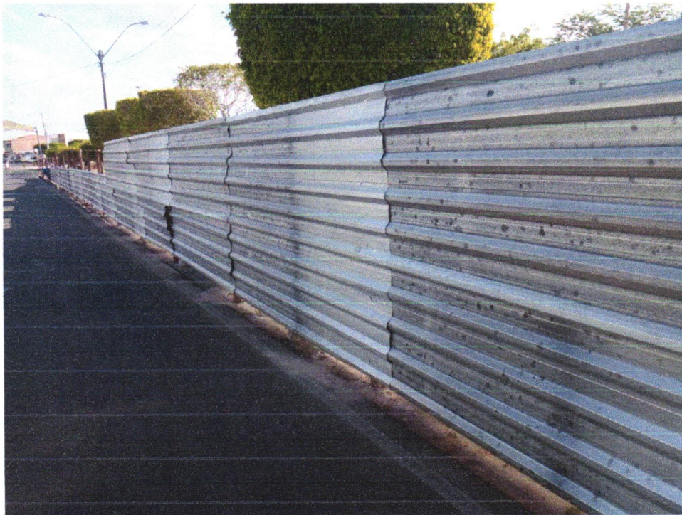
Foto 01 - TAPUME COM TELHA METÁLICA. AF_05/2018
